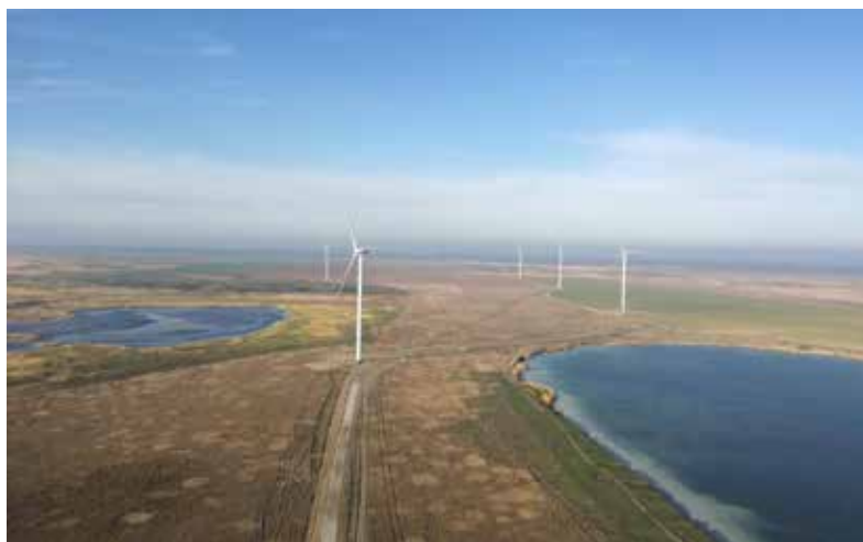
Рис. 2.65 Об'єкти вітроенергетики у Північному причорномор'ї
