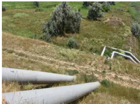
Рис. 2.67 Будівництво сифону для перенаправлення води із Північно-Кримського каналу
