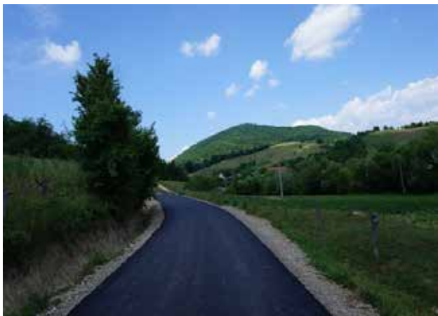
Рис. 2.41 Новозбудована автодорога до урочища Чорна Вода
