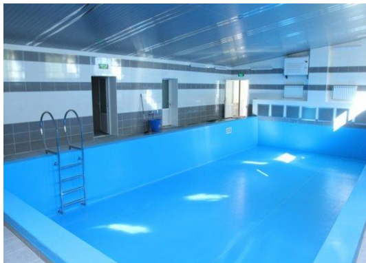
Реконструкція приміщень басейну Полтавської гімназії
