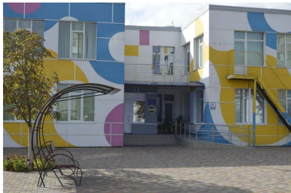
Капітальний ремонт із заміною вікон у 10 закладах освіти
