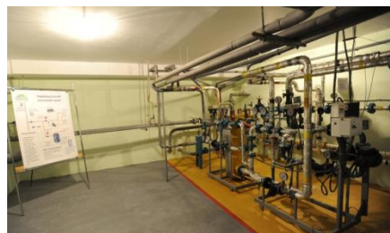
Реконструкція системи тепlopостачання та водопостачання у 5 закладах освіти
